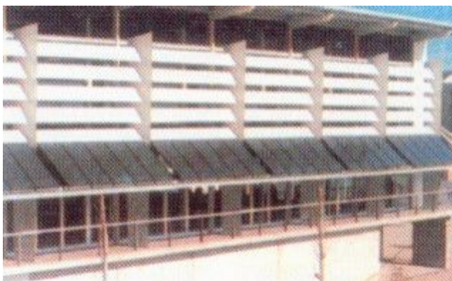
Un edifici amb panells fotovoltaics.
