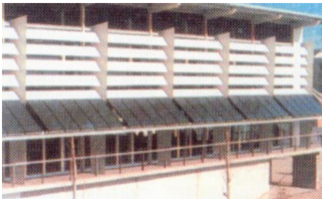
Un edifici amb panells fotovoltaics.
