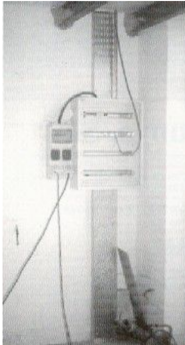
Un detall de la instal·lació del quadre elèctric.
