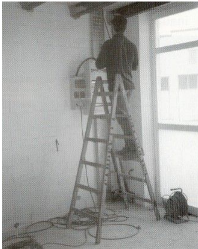
Els treballs elèctrics que marquen la recta final de les obres.
