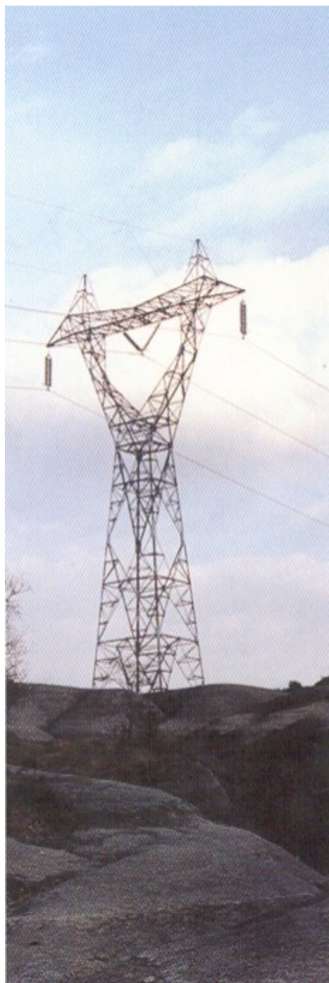
Torre d'alta tensió d'Osona.
