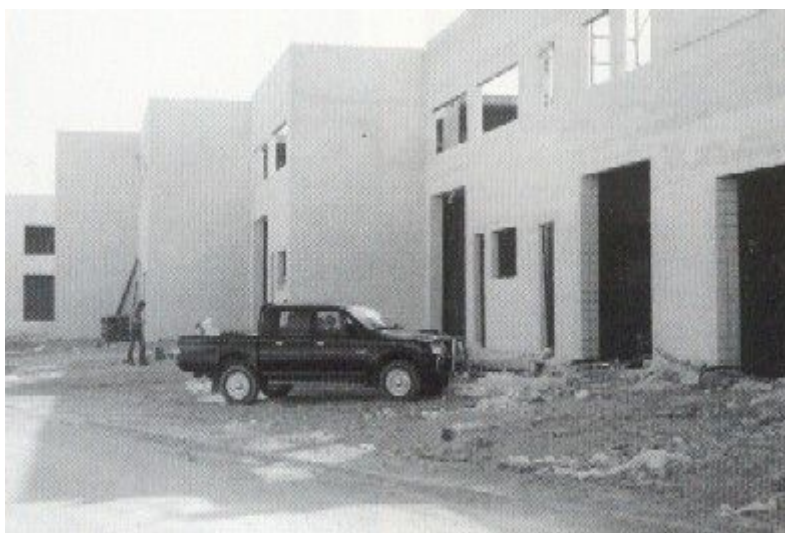
Les obres de totes les naus ja comencen a tenir bon aspecte.
