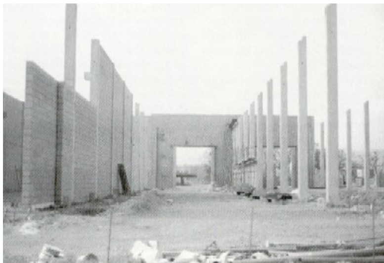
L'estat actual de les obres del futur local d'AICO.
